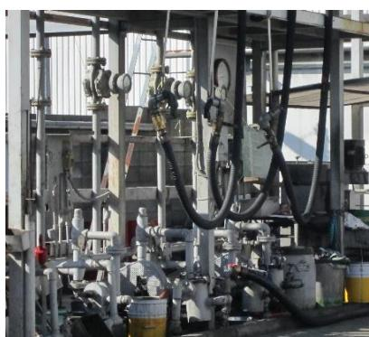
排出事業者様より回収した廃油は、自社工場にて、成分分析→加熱処理→遠心分離→濾過の工程を経て再生重油にリサイクルしています。
